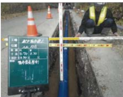
配水管布設替工事
