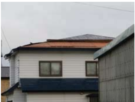
台風19号で屋根トタンが飛び、被災した住家
