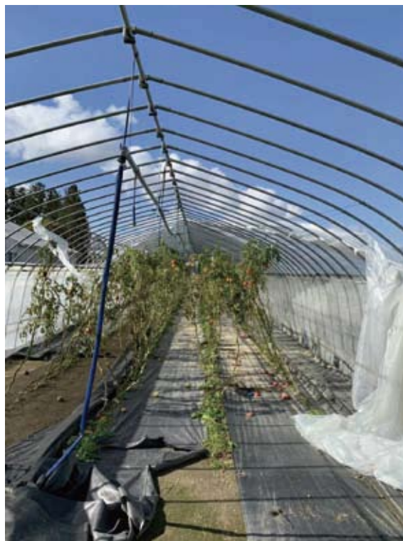
台風19号で被害を受けた農業用パイプハウス
