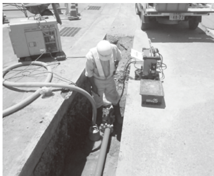
給水管の入れ替え工事
