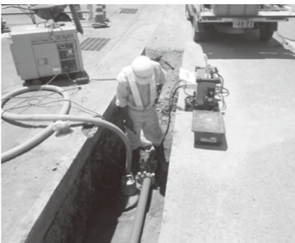
給水管の入れ替え工事
