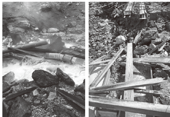
破損した温泉配水管（左）と湯桶（右）
