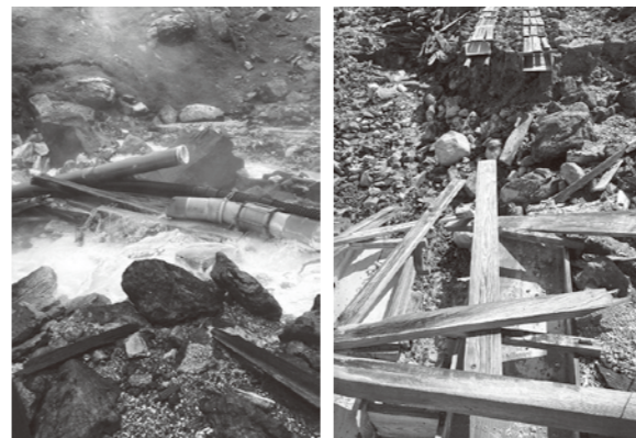
破損した温泉配水管（左）と湯桶（右）
