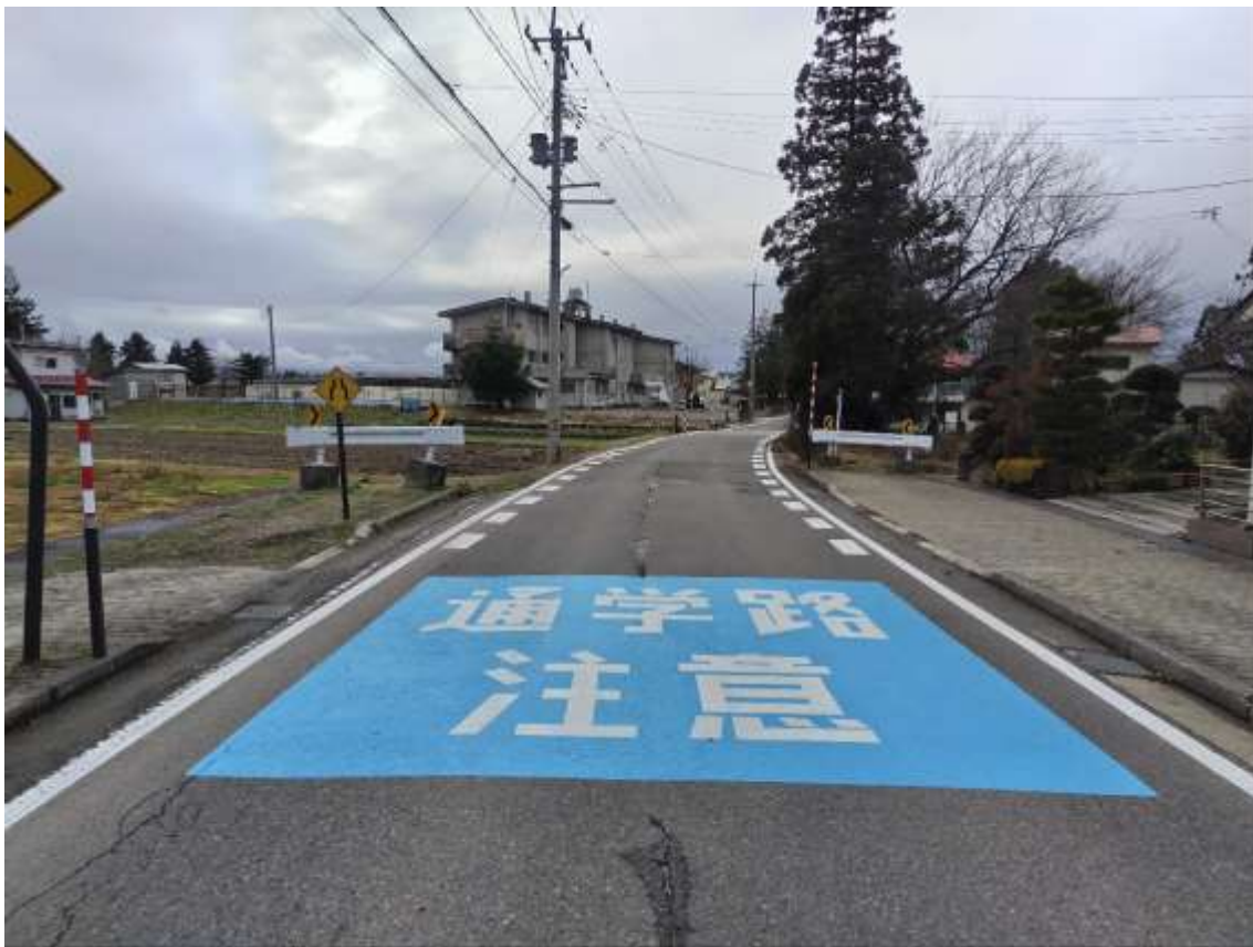
仮対策後（路面標示・外側線・注意喚起看板）
