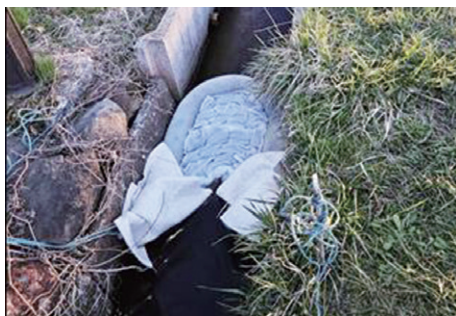
油が流出した場合は、オイルマットなどを設置して被害拡大を防ぎましょう
