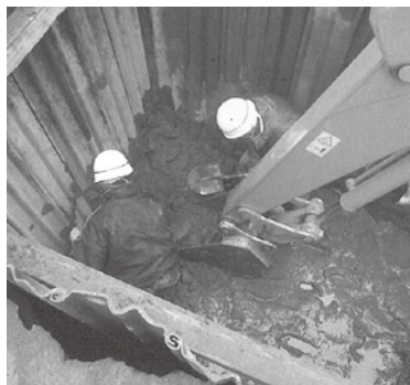
下水道工事の掘削状況
