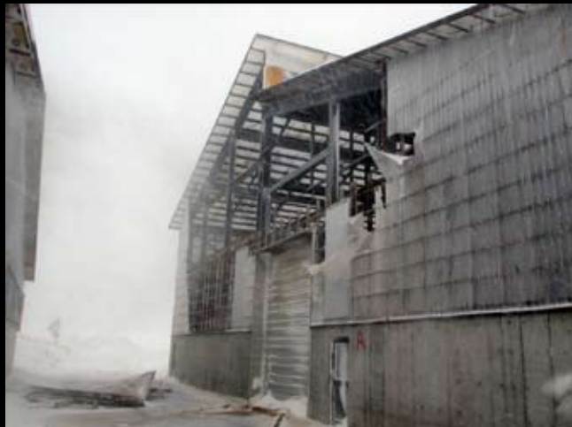
外壁が損壊した優良堆肥製造施設。施設の中には大量の雪が吹き込んだ
