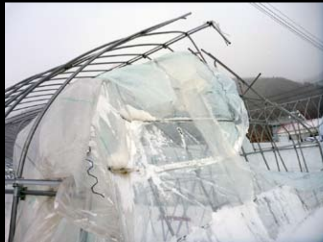
ビニールが剥がれ、骨組みが変形した農業用パイプハウス。ビニールが掛かったハウスは風の影響を受けやすく、特に被害が大きかった
