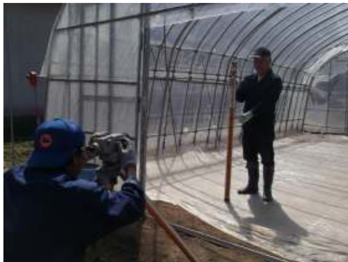
ハウス内の測量作業
